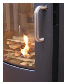
4. Wanneer u (na 5 à 10 minuten) ziet dat de schoorsteen warm genoeg is om te trekken, sluit u het deurtje. Als aan alle voorwaarden is voldaan, vormt er zich na nog eens 15 à 20 minuten een dikke gloeiende laag in de verbrandingskamer. Tegelijk heerst er in de verbrandingskamer een hoge temperatuur, die nodig is om de verbranding voort te zetten.
