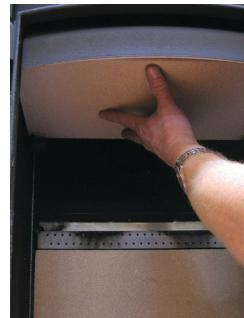
6. Il faut s'assurer que les chicanes pour la fumée et les briques sont à nouveau correctement montées avant de faire du feu après un nettoyage.
